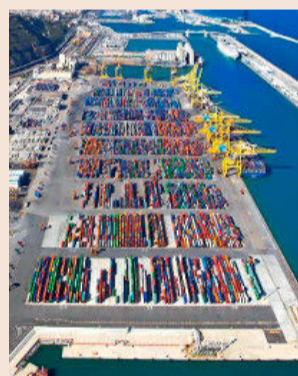
Instalaciones de APM en el Puerto de Barcelona.
