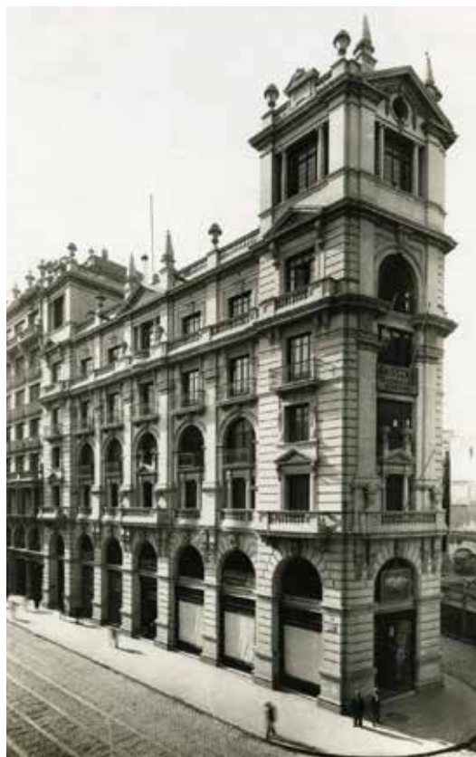
El nostre edifici, ja construït, anys 1928-1929 (Arxiu Nacional de Catalunya)
