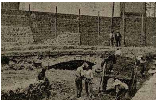
Fig. 10. Estat de les obres a l'agost 1922 ( Técnica , núm. 44, agost 1922, p. 185).
