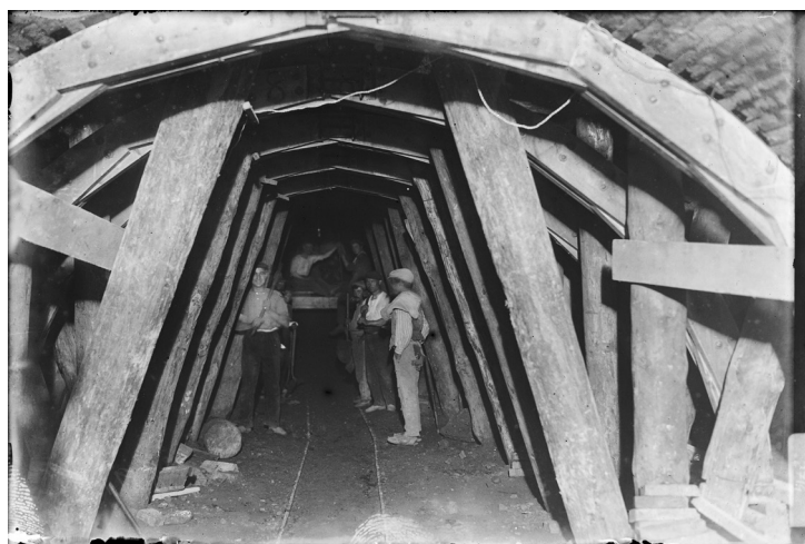
Fig. 13.- Túnel en construcció. 1924. Arxiu Nacional de Catalunya, col·lecció FGC.
