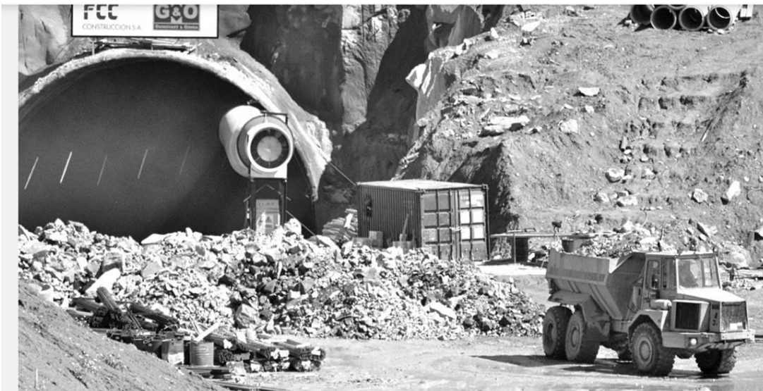
Imatge de les obres de Bracons (Territori Scot)
