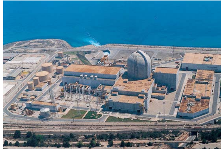
CENTRAL NUCLEAR DE VANDELLÓS II
