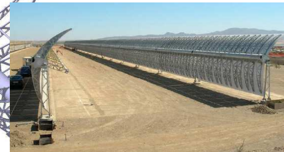
Nueva estructura diseñada por la empresa SENER para colectores cilindro parabólicos de gran tamaño
