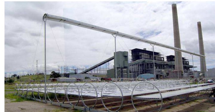
Prototipo de concentrador lineal Fresnel montado en Australia
