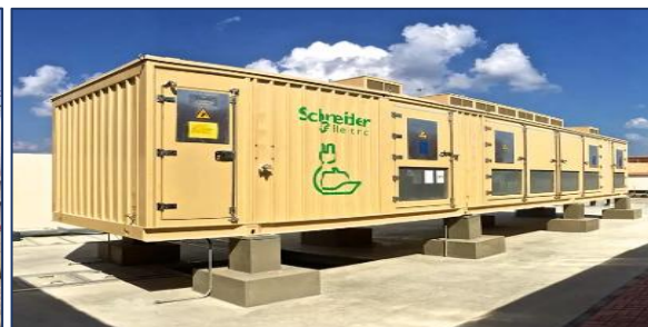
2 Módulo OPS. Convierte voltaje y frecuencia.
