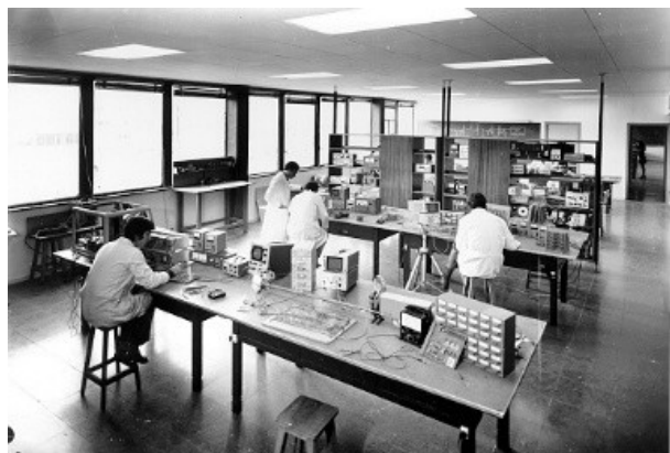
El Laboratori d'Automàtica a la planta 2 de l'ETSEIB a la Diagonal.
