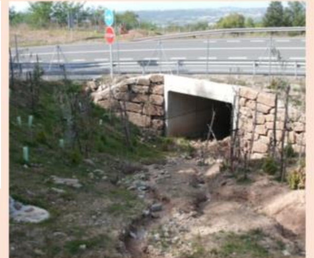
Imatge 4. Obra de fàbrica sota una carretera per al pas de fauna.
