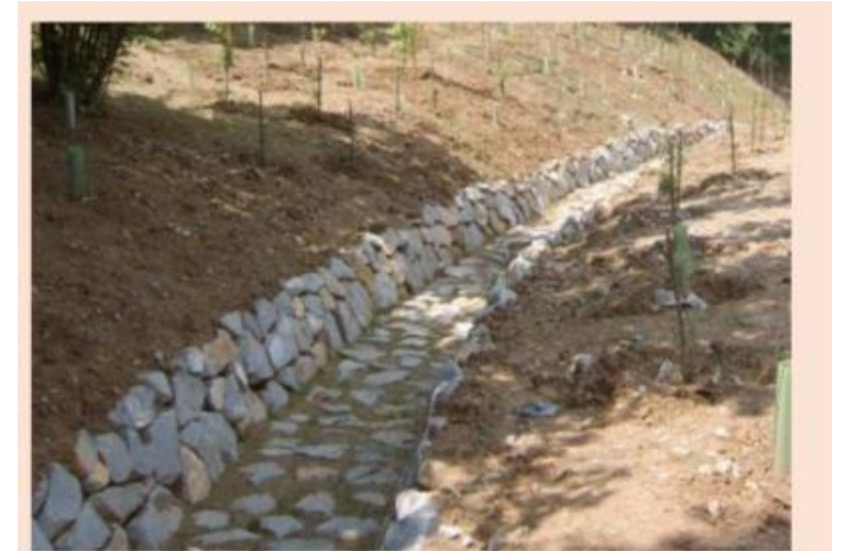
Imatge 2. Vista d'una cuneta amb revestiment de pedra
