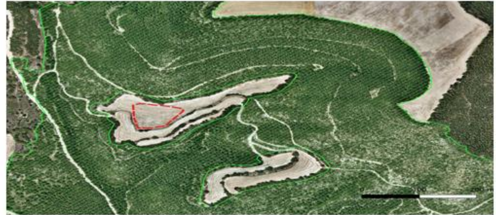
Ubicació d'una BESS envoltada d'hàbitat natural
