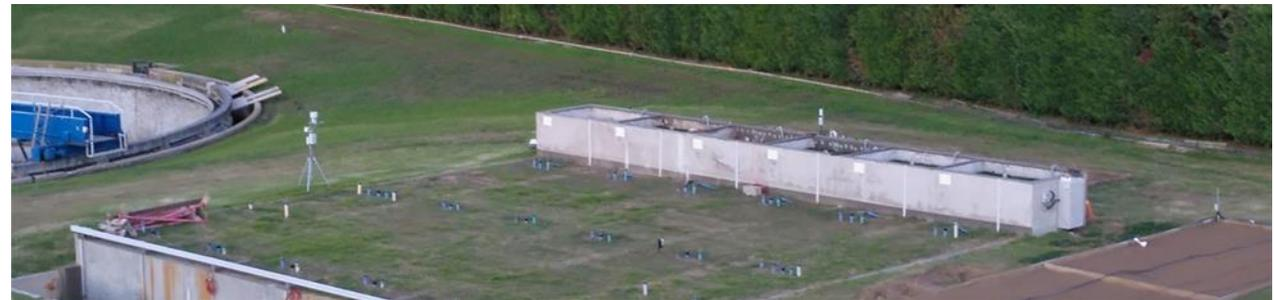
La planta piloto de Palamós ha estado recargando el efluente del secundario a través de una balsa con capa reactiva y plantas, durante cuatro años sin apenas eventos de colmatación. Se ha demostrado la eliminación de patógenos, emergentes (productos farmacéuticos, filtros solares, etc.) e incluso, la reducción de genes de resistencia a antibióticos
