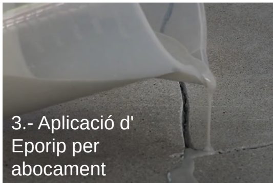
4.- Fissura saturada de resina Eporip
