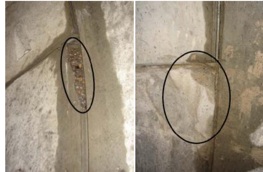
Roturas y reparaciones de esquinas, especialmente en anillos armados
