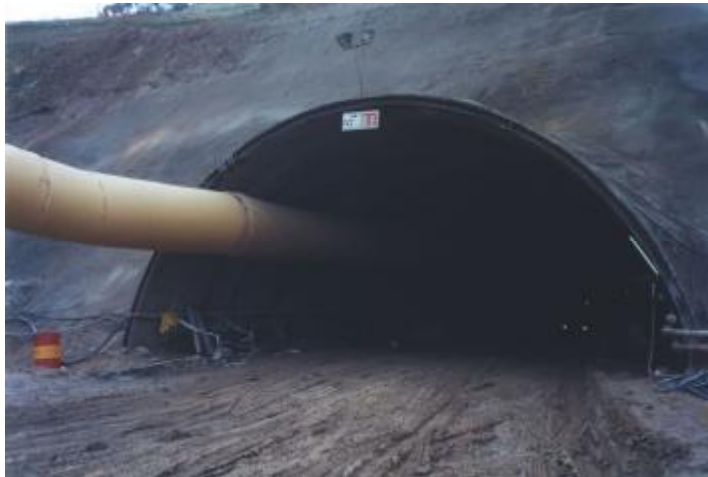
Túnel de Bracons
