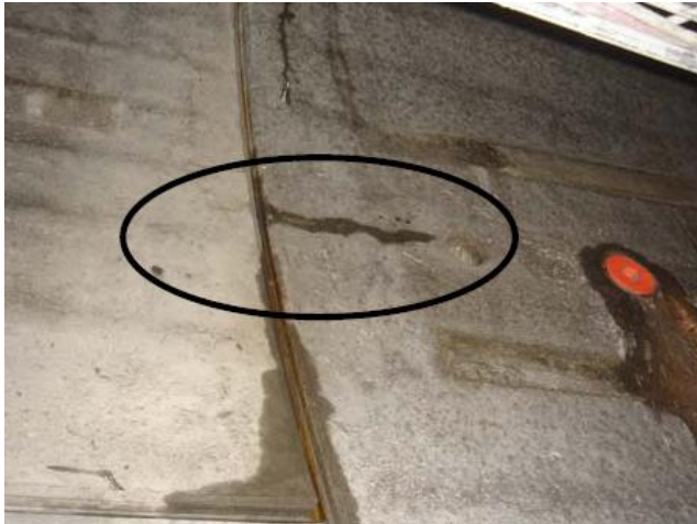
Fisura aislada en una dovela convencional debido a efectos locales.
