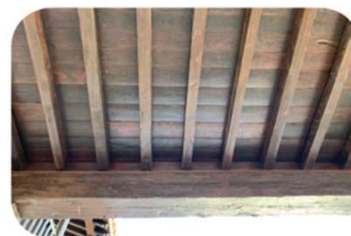
Refuerzo de estructuras de madera
