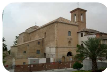
Refuerzo de estructuras de albañilería
