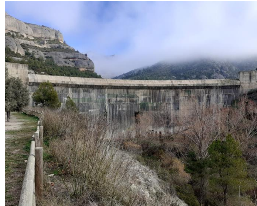
Parament aigües avall de l'embassament de Margalef.
