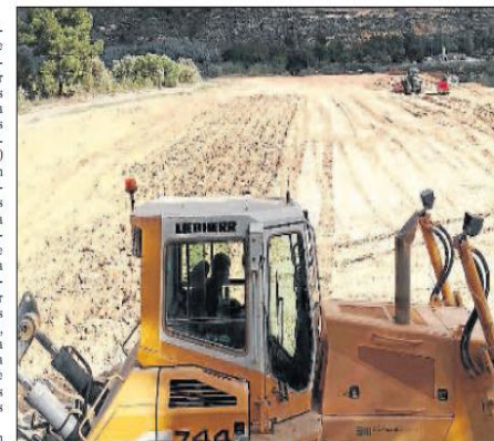
Preparació dels terrenys per a una planta solar de la comunitat del Garrigues Sud a Flix.
