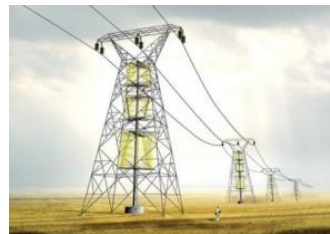
Líneas eléctricas de gran distancia con baja carga.
