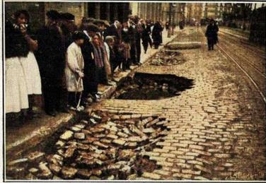
Destrozos causados en el pavimento por la explosión de una cañería de gas, ocurrida en la noche del 11 del actual
