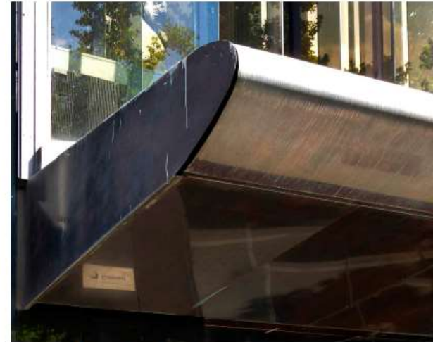
Vista de detalle de la marquesina en Av. Diagonal | Estado actual
