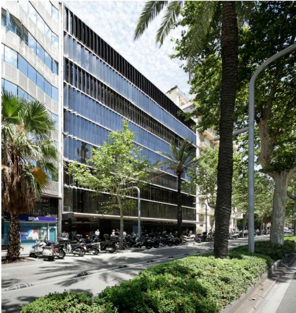
Vista de la fachada Av. Diagonal | Estado actual
