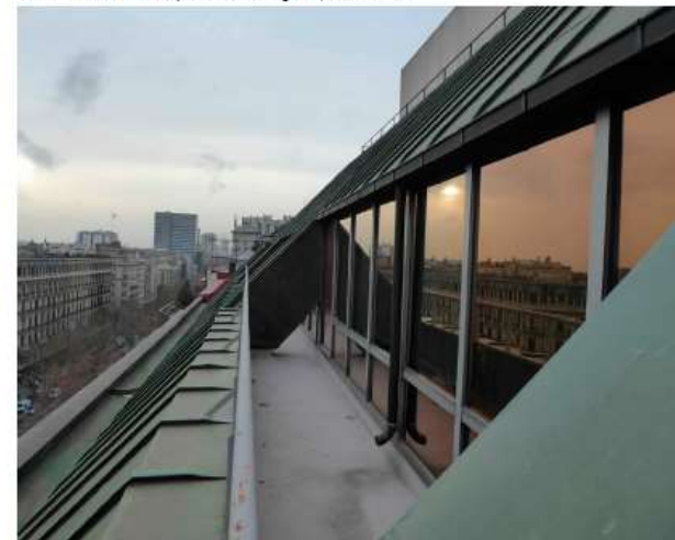
Vista de la cubierta Av. Diagonal | Estado actual
