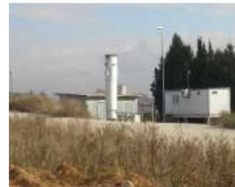
TORXA DE COMBUSTIÓ DE BIOGAS
