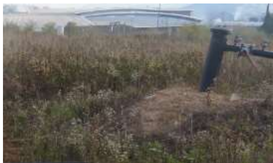
POUS DE CAPTACIÓ PRIMARIS
