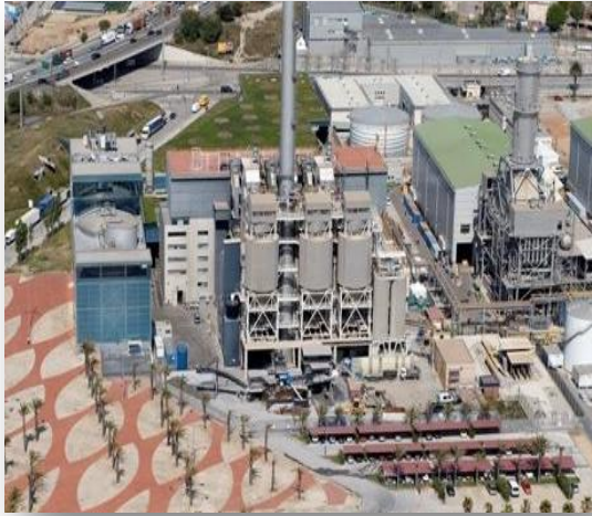
Incineradora del Besos
