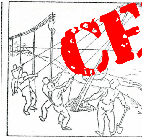
Després de col·locar els rails del telègraf posen els fils.
