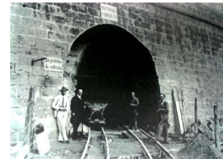
Túnel Port /Via doble
