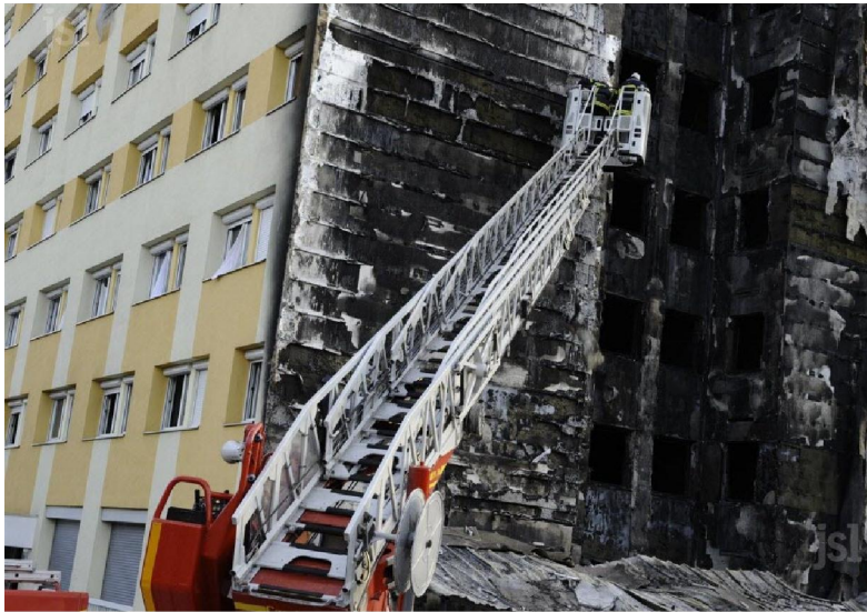
Edificio residencial La Fontaine d'Ouche. Dijon – Francia (9 plantas) 14/11/2010 SATE EPS + barreras de lana mineral
