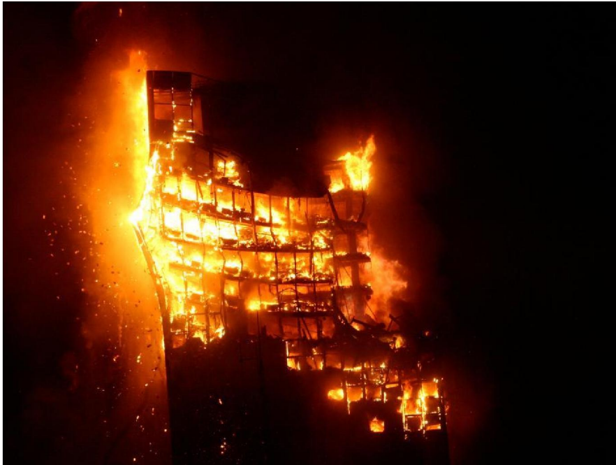
Edificio Windsor Madrid (España) 12/02/2005
