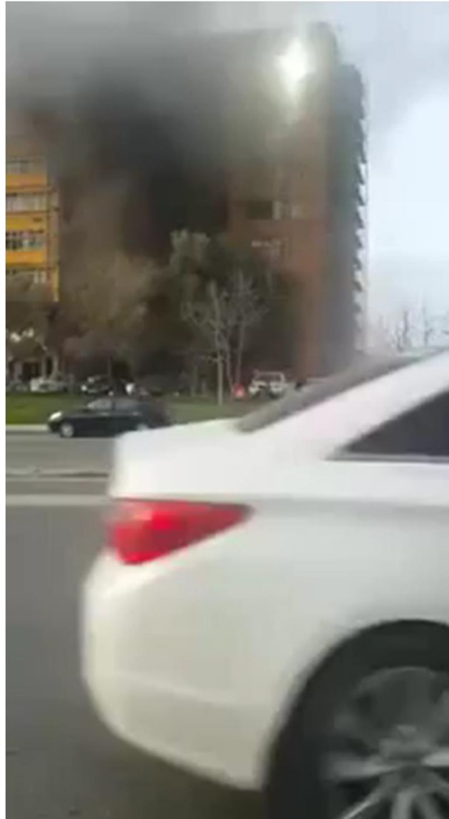
Edificio residencial (13 plantas) Baku-Azerbaián. Nov/2015 Presumiblemente paneles MCM
