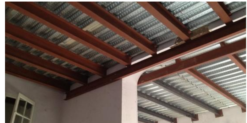
[ Figura 5.4.1 Elements convencionals del sostre d'estructura mixta d'un edifici ]
