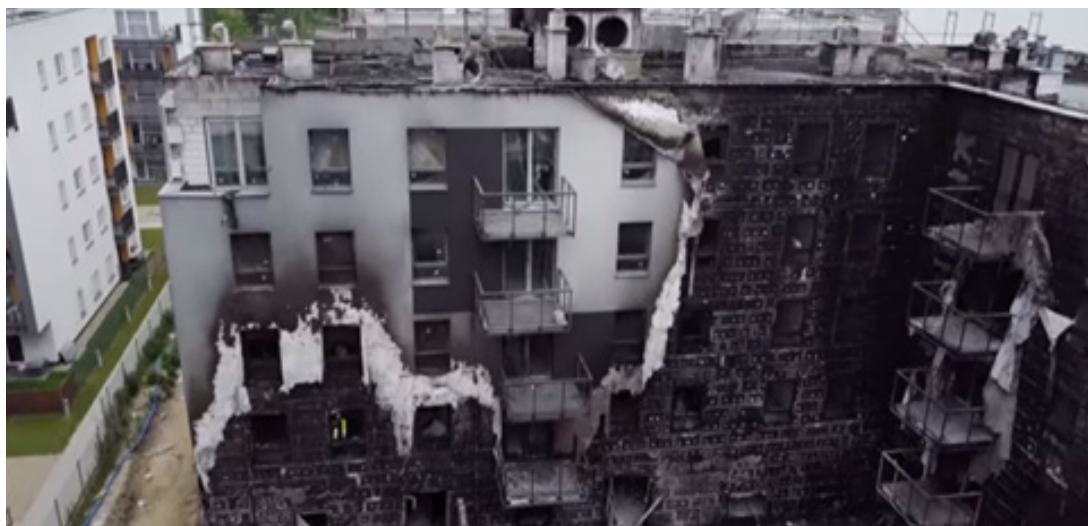
Figura 2.14. Incendi de façana amb sistema SATE de material aïllant sense determinar. Edifici Belleville, Breslavia, Polònia, 19.5.2017. Font: Lotnicze Fotopolska
