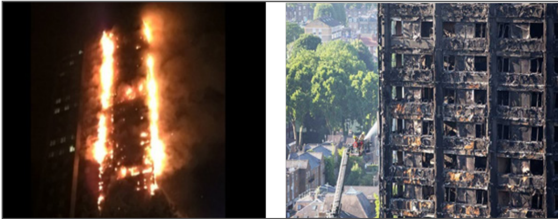
Figura 2.10. Imagen del incendio del edificio Grenfell donde se aprecia la propagación del fuego a lo largo de los pilares salientes de las fachadas (izquierda). Imagen del edificio Grenfell después del incendio.
