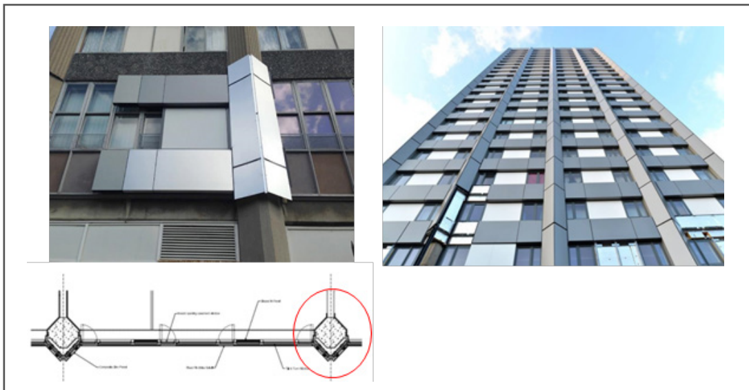
Figura 2.9. Imagen del estudio inicial de la fachada ventilada del edificio Grenfell y del detalle en planta de la resolución de los pilares salientes (izquierda). Imagen de la rehabilitación de la fachada casi finalizada (derecha).
