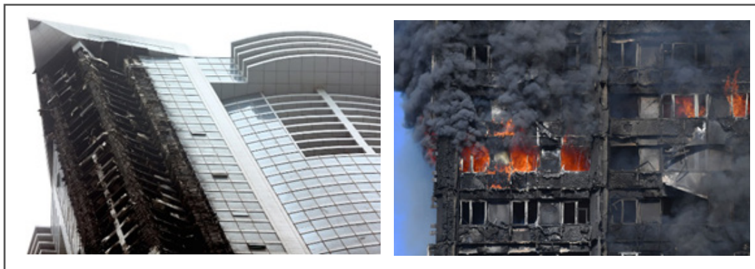
Figura 2.12. El edificio Torch Tower (Dubái) ha sufrido dos incendios en dos años, en marzo de 2015 el primero (izquierda) y en agosto de 2017 el segundo. Incendio de la Torre Grenfell junio de 2017 (derecha).
