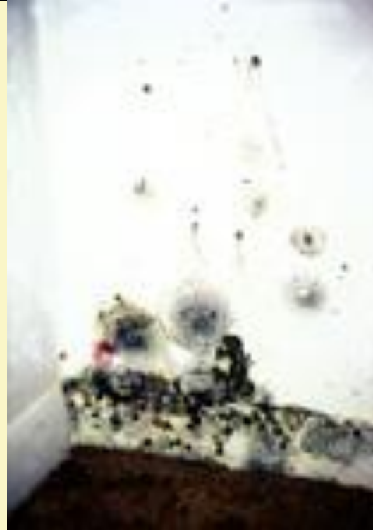
Creixement de fongs en un interior per condensació de la humitat de l'aire
