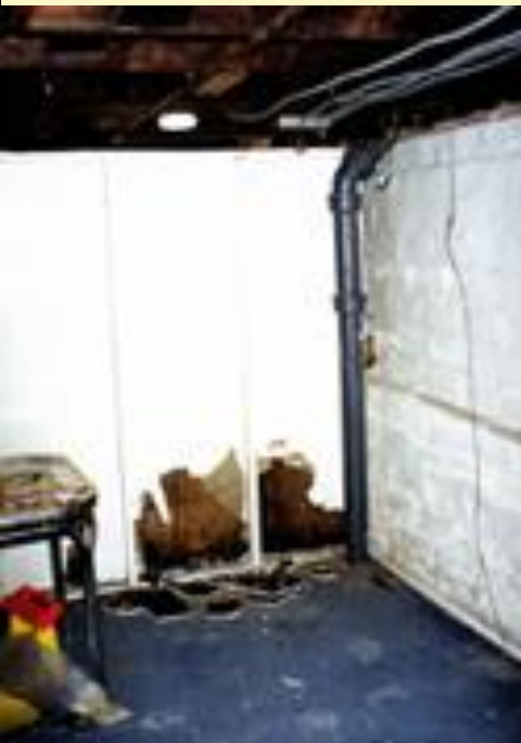
Frontalment els panells semblen estar bé però la part posterior està recoberta de fongs
