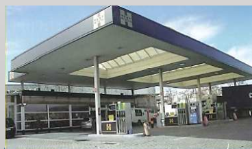
GENERAL DE GASOLINERAS
