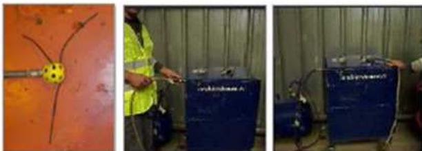
Latiguillo y compresor utilizados para la limpieza interior del conducto con aire a presión
