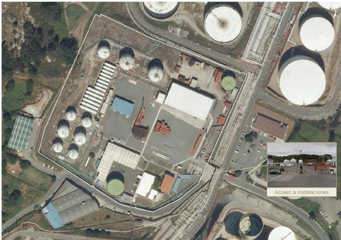
Figura 18. Localización de accesos ás instalacións de Repsol Butano, S.A.
