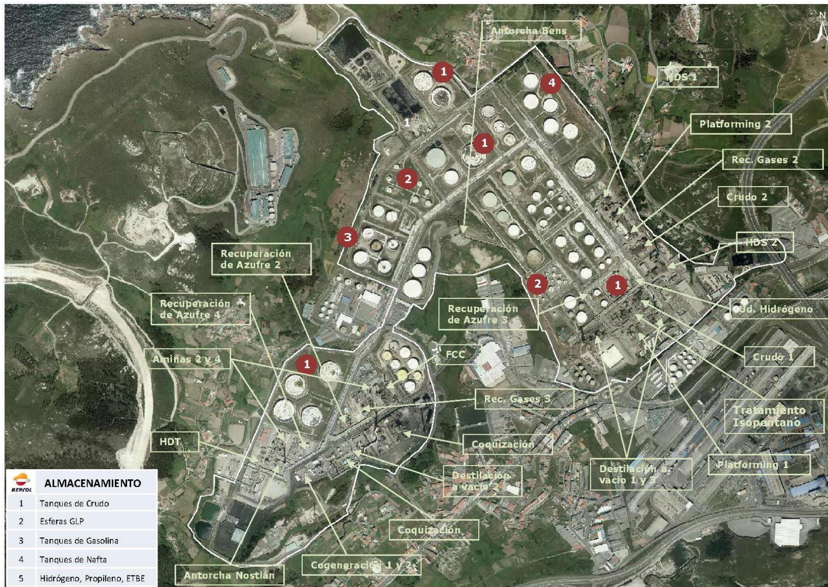
Figura 12. Localización substancias clasificadas en Repsol Petróleo, S.A.
