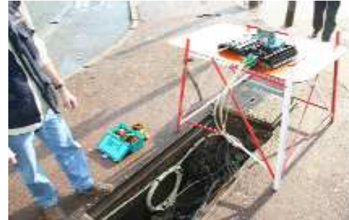
instal.lació de fibra òptica
