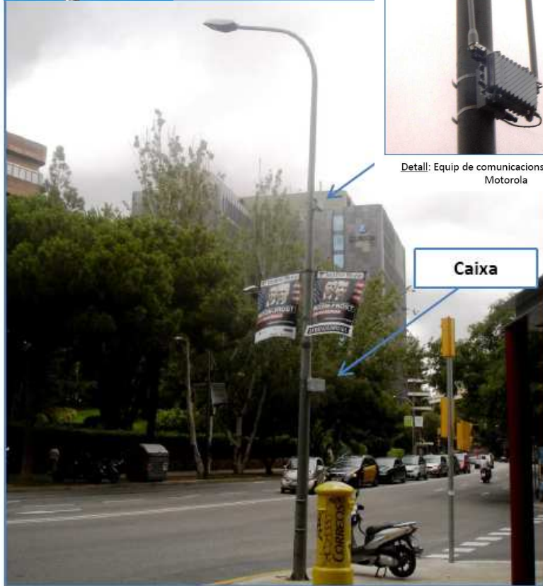
Instal·lació de node a fanal: caixa + equip WiFi
